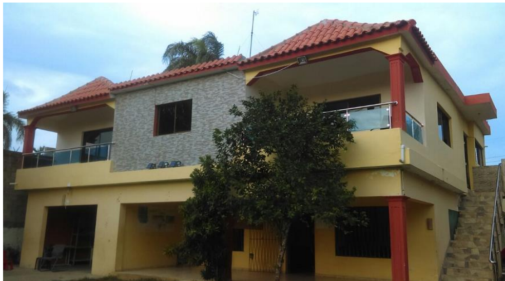
Vue de la maison entière avec le 1er étage
